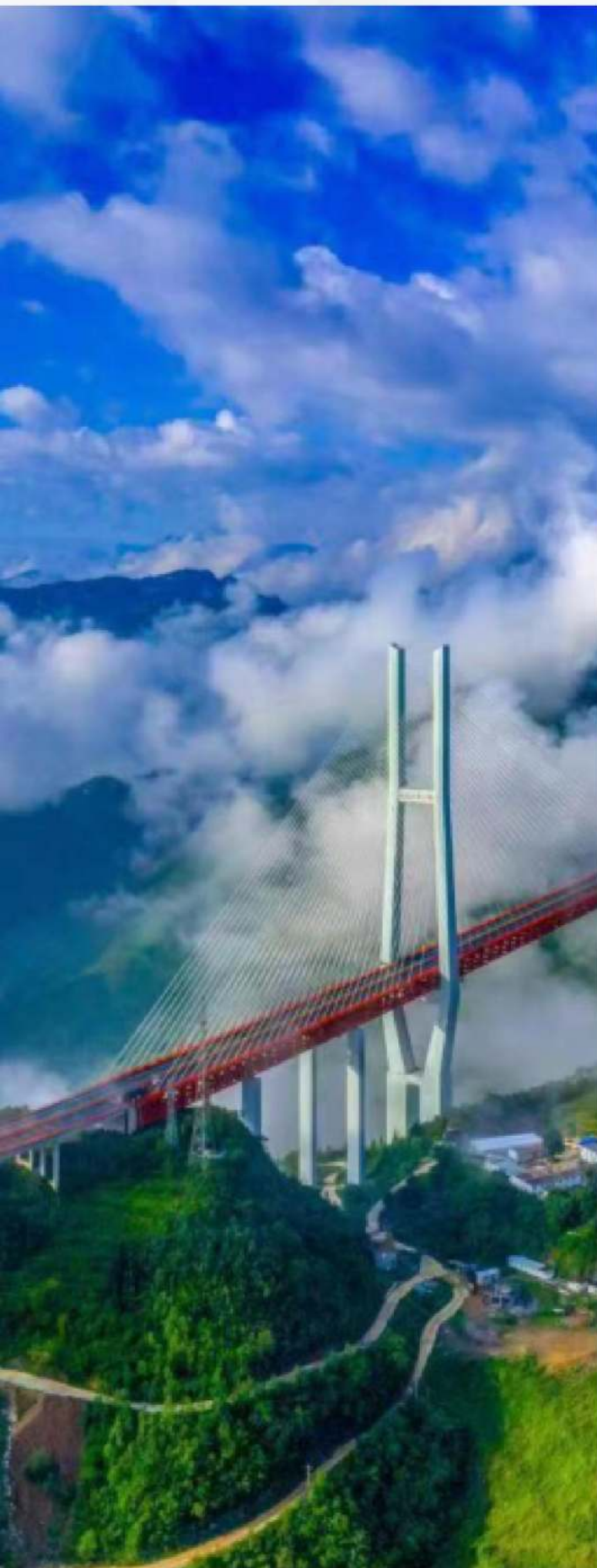
圖：世界第一高橋——北盤江大橋 來源：六盤水市人民政府網站
